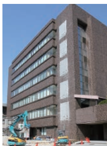
工事中の9号館エレベーター棟
