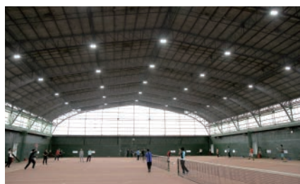
多目的屋内競技場LED照明
